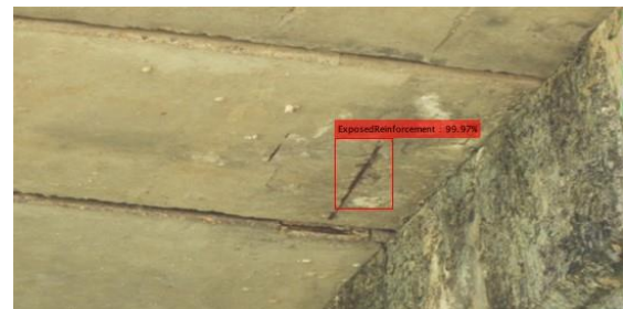
รูปที่ 4.6 ตัวอย่างผลลัพธ์การตรวจจับ ExposedReinforcement
