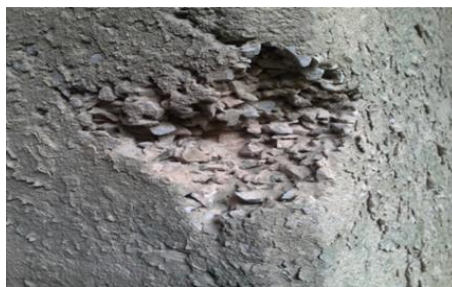
รูปที่ 2.8 ตัวอย่างความเสียหายชนิด Spalling
