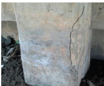
รูปที่ 2.7 ตัวอย่างความเสียหายชนิด Cracking
