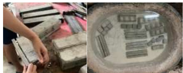
รูปที่ 7 แกะชิ้นงานออกจากแบบ รูปที่ 8 นำชิ้นงานไปแช่น้ำ
