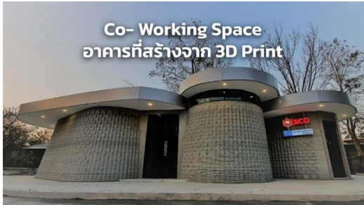
รูปที่ 1 Co-Working Space by SCG อาคารที่สร้างด้วยการพิมพ์สามมิติ
