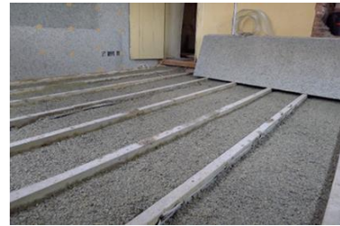
รูปที่ 6 ชั้นของพื้นฉนวนจากเฮมพ์กรีต [20]
