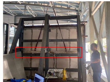
รูปที่ 8 การติดตั้งคานเหล็ก
