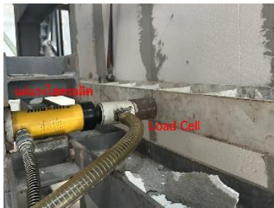
รูปที่ 11 การติดตั้ง Hydraulic Jack เข้ากับ Load Cell
