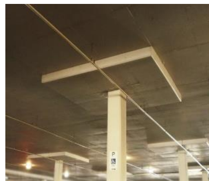
รูปที่ 2.4 การเพิ่มแผ่นหัวเสา
