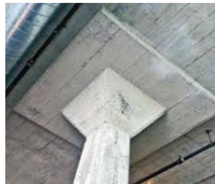
รูปที่ 2.3 การเพิ่มหมวกเสา
