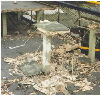
รูปที่ 2.1 การวิบัติเนื่องจากแรงเฉือนทะเล
