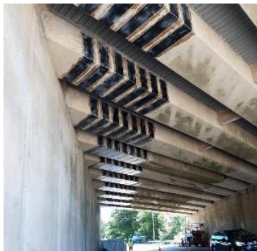
รูปที่ 2.5 การใช้คอนกรีตเสริม FRP
