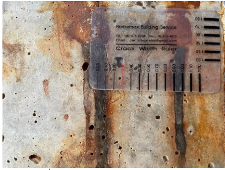
รูปภาพที่ 8 รอยร้าวของคอนกรีต 0.01 มิลลิเมตร
