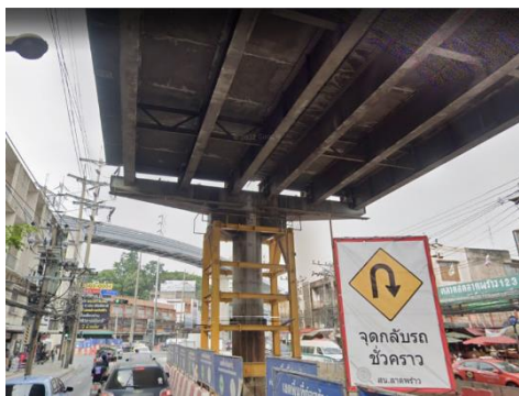
รูปที่ 8 สะพานข้ามแยกบางกะปิ
